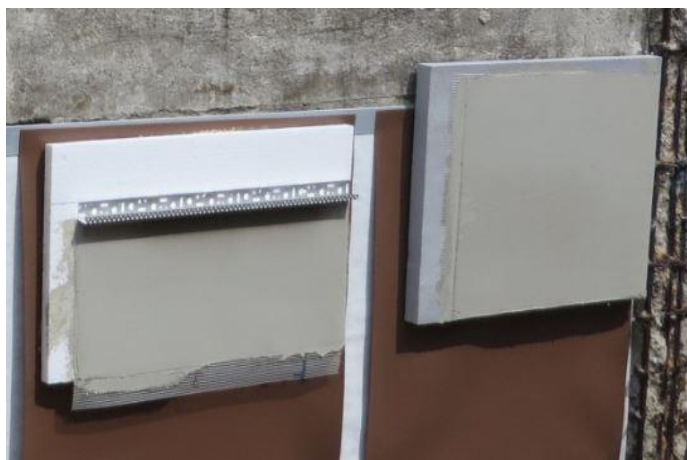
Obrázek č. 21: Vyzrálý podklad pro finální povrchovou úpravu
