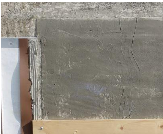
Obrázek č. 5: Sjednocení savosti podkladu a vytvoření adhezního můstku disperzní penetrací
