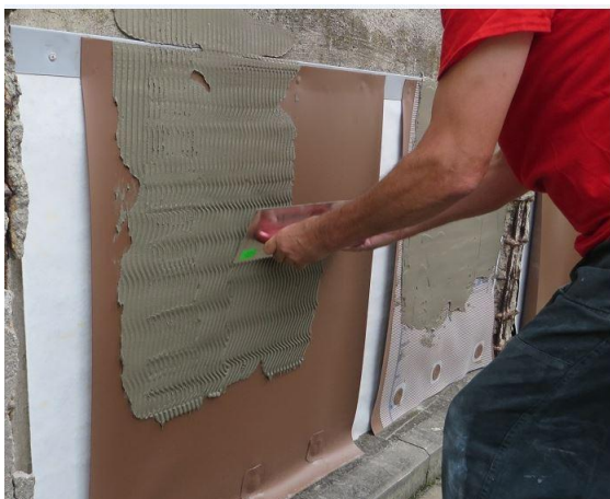
Obrázek č. 3 a 4: Aplikace tmelu na fólii zubovým hladítkem
