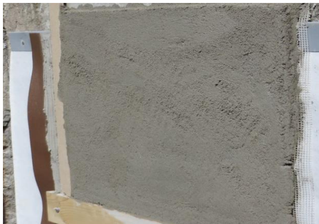
Obrázek č. 6: Jádrová silikátová omítka nanášená ručně, stažená dřevěným hladítkem
