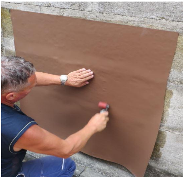
Obrázek č. 26: Zaválečkování lepených ploch pryžovým válečkem
