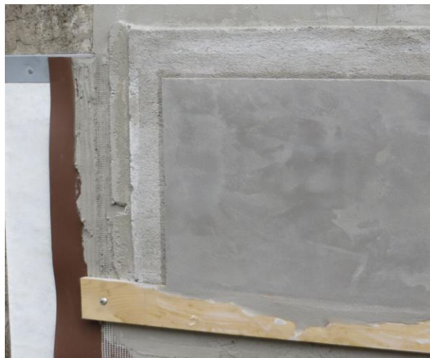
Obrázek č. 8: Dokončená štuková omítky hlazená plstí
