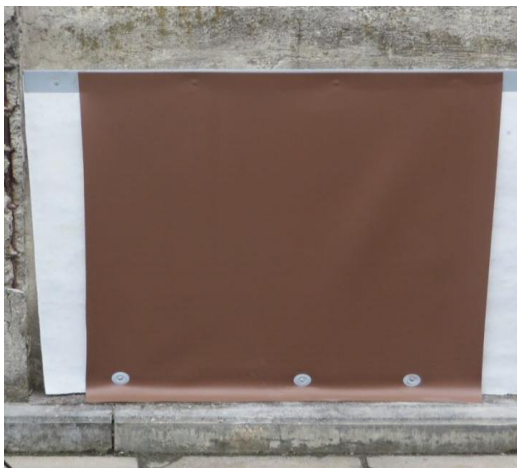
Obrázek č. 1: Nainstalovaný vzorek fólie FATRAFOL 803
