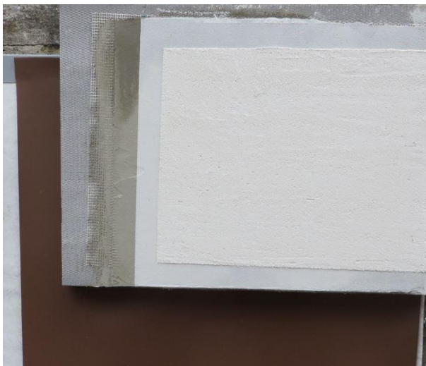
Obrázek č. 22: Strukturní omítka na XPS podkladu
