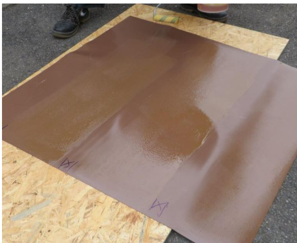
Obrázek č. 24: Aplikace lepidla na rubovou stranu fólie
