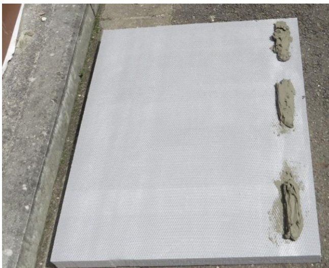
Obrázek č. 18: Nanesení lepicího tmelu po obvodu XPS desky
