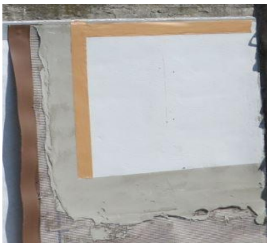
Obrázek č. 9: Sjednocení savosti podkladu a zvýšení adheze - silikonová penetrace MUREXIN
