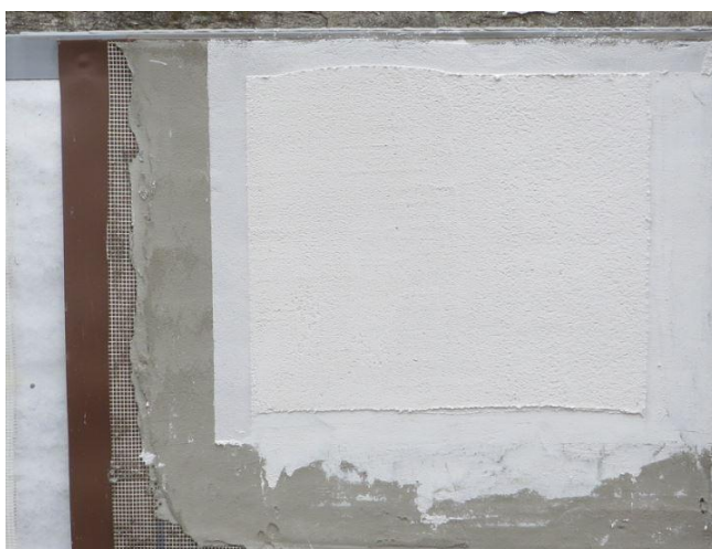
Obrázek č. 10: Finální strukturovací silikonová omítky Weber, nanesená plastovým hladítkem
