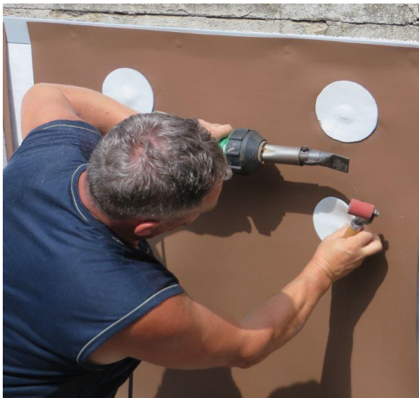
Obrázek č. 16: Navaření terčů fólie FATRAFOL 807 tl. 2,6 mm
