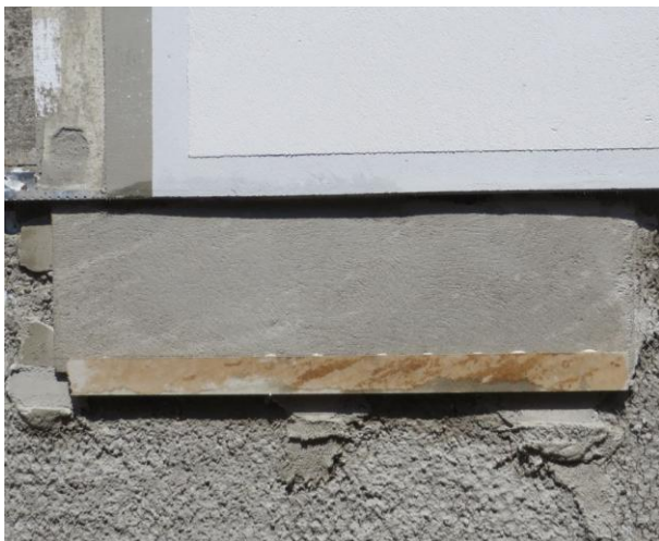
Obrázek č. 30: Srovnání podkladu jádrovou omítkou Weber
