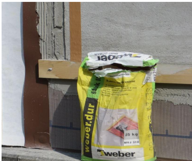
Obrázek č. 7: Příprava pro jemnozrnnou štukovou omítku
