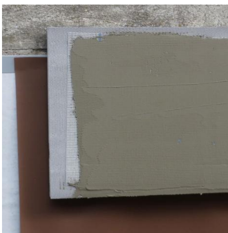
Obrázek č. 20: Aplikace lepicího tmelu s výztužnou skleněnou tkaninou
