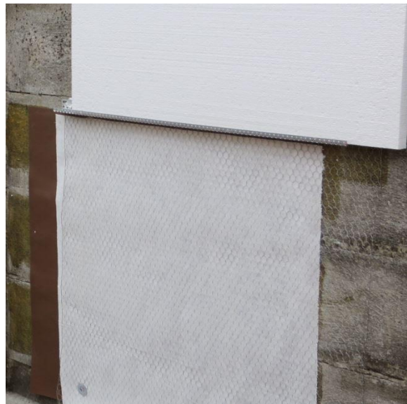
Obrázek č. 27: Instalace separační textilie a výztužné vložky
