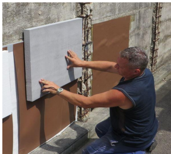
Obrázek č. 19: Osazení XPS desky na terče s lepidlem
