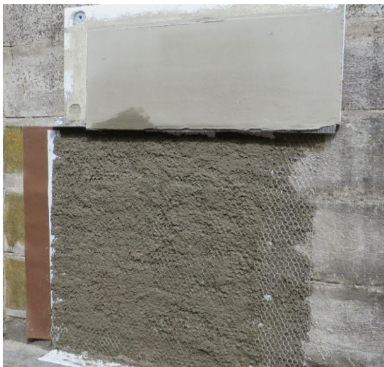
Obrázek č. 28: Čerstvě aplikovaný cementový postřík
