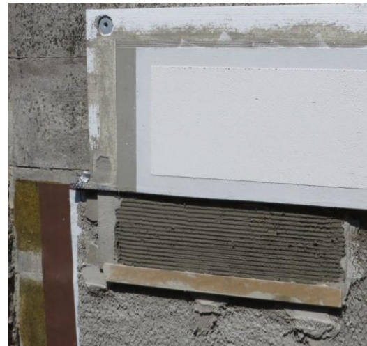
Obrázek č. 31: Lepicí exteriérový tmel na penetraci MUREXIN
