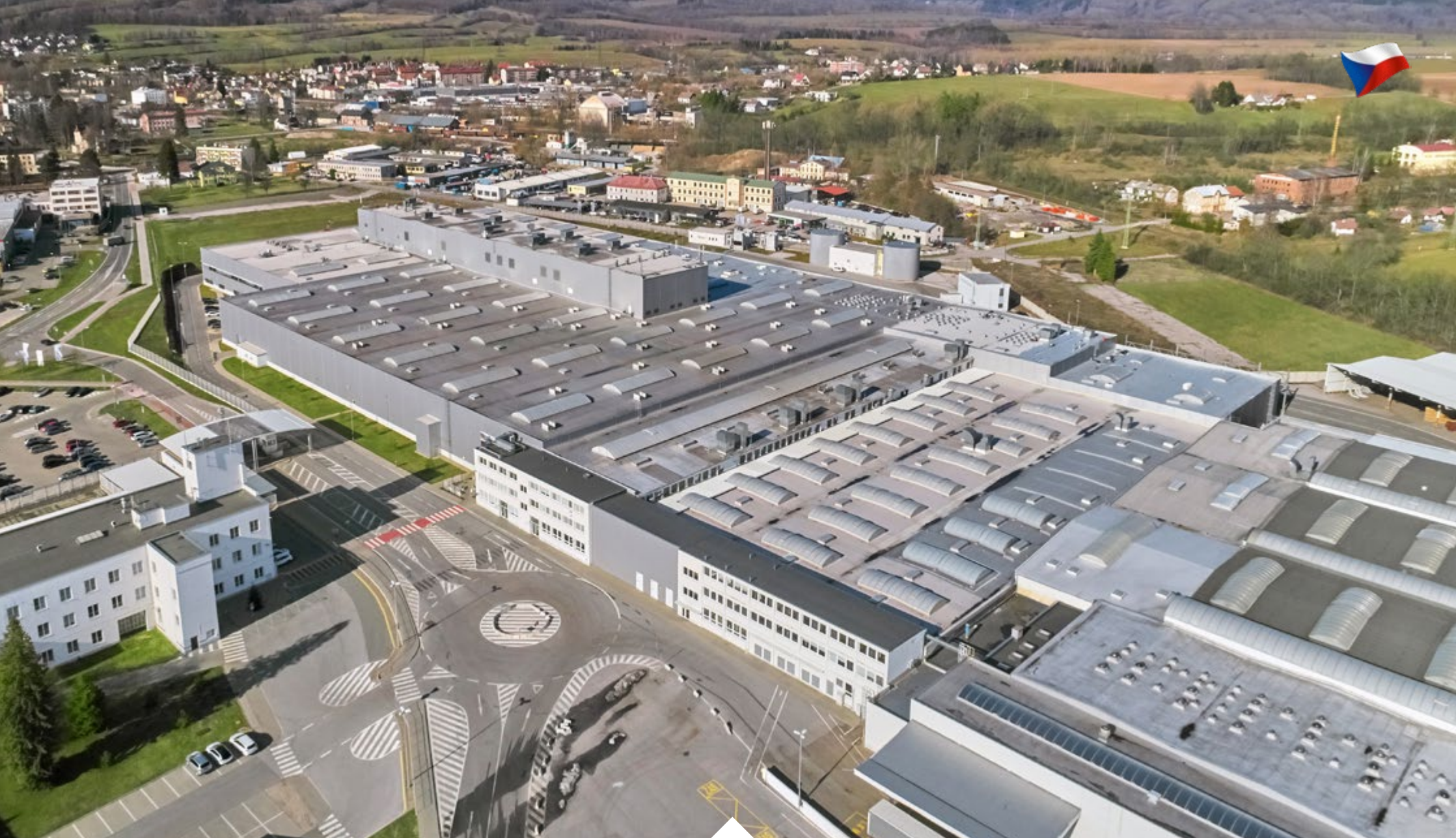
ŠKODA AUTO a.s., VÝROBNÍ HALA M2 | ŠKODA AUTO COMPANY, PRODUCTION HALL M2 - VRCHLABÍ
