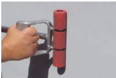
Stlačení lepených ploch ručním válečkem
