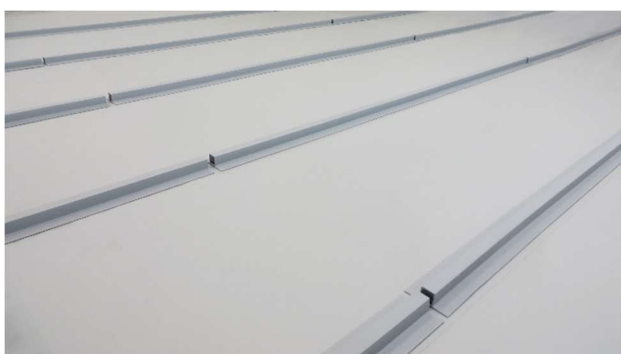
Obr. 24: Pokládání profilů na vytyčenou plochu střechy
