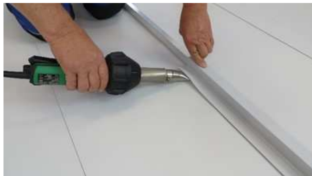
Obr. 6: Bodové přichycení zkušebního profilu k podkladu
