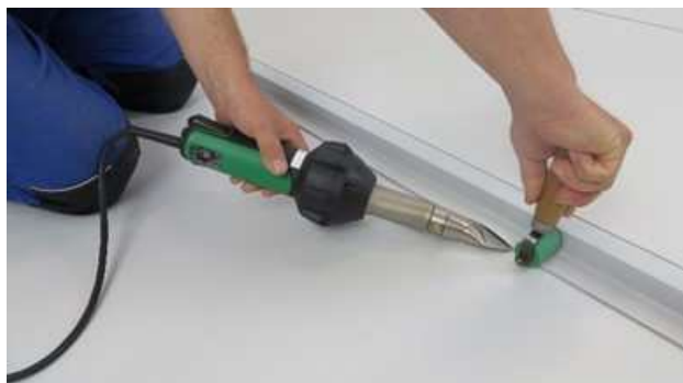
Obr. 25: Navařování profilu ručním svařovacím přístrojem
