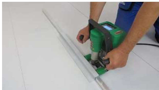
Obr. 8: Provedení spoje z obou stran zkušebního profilu
