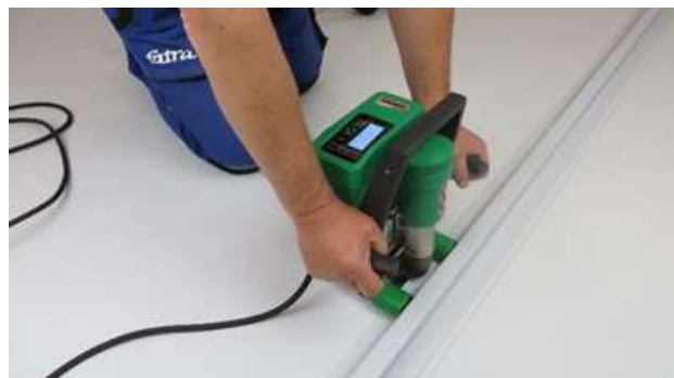
Obr. 26: Navařování profilu poloautomatickým svařovacím přístrojem
