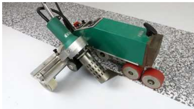
Obr. 3: Navařování dlaždic FATRAFOL WALK 600
