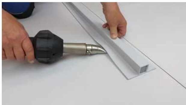
Obr. 23: Fixace profilu druhým bodovým svarem
