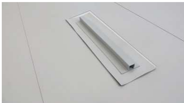
Obr. 9: Vyříznutí zkušební vzorku z plochy střechy
