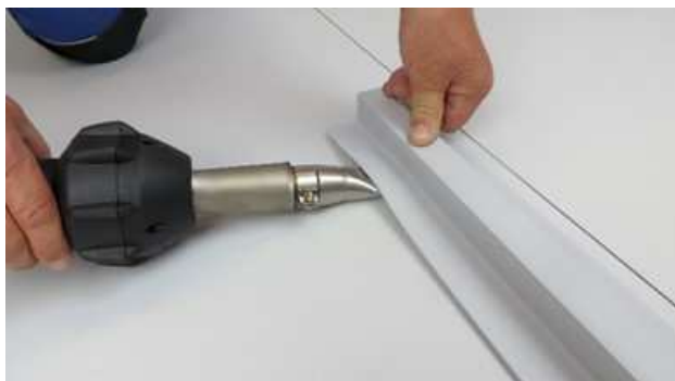
Obr. 22: Fixace profilu prvním bodovým svarem
