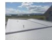
Obr. 1. 3. Střešní konstrukce s PVC fólií
